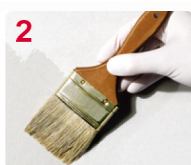
2 APLIQUE SELLADOR FIJADOR
